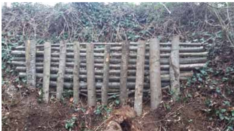
Chemin pédestre à proximité de la maison des abeilles : installation de fascines
